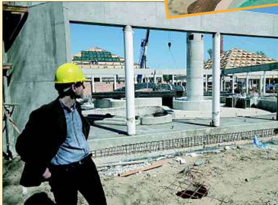
Niecka basenu sportowego jest już wylana.
